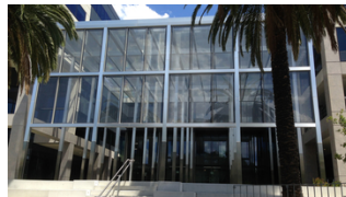
Poste australiane, Westin Melbourne, AU
