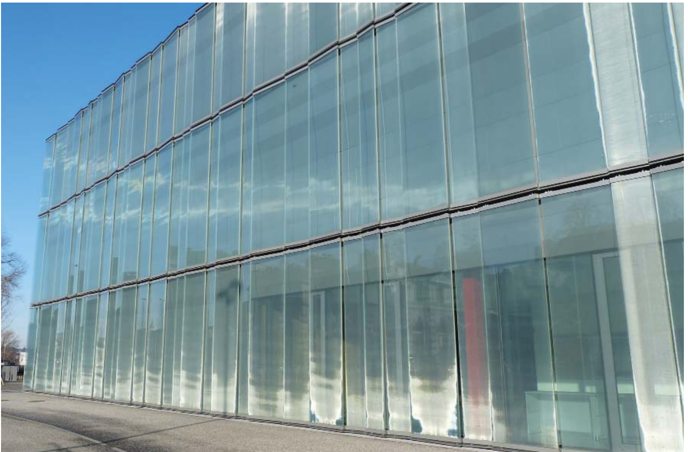
Abb. 2. Die Südwestecke des WÜRTH-Gebäudes. Hier besteht die ganze Fassade aus Glas, in welches alubeschichtetes SEFAR-Gewebe einlaminiert worden ist.
