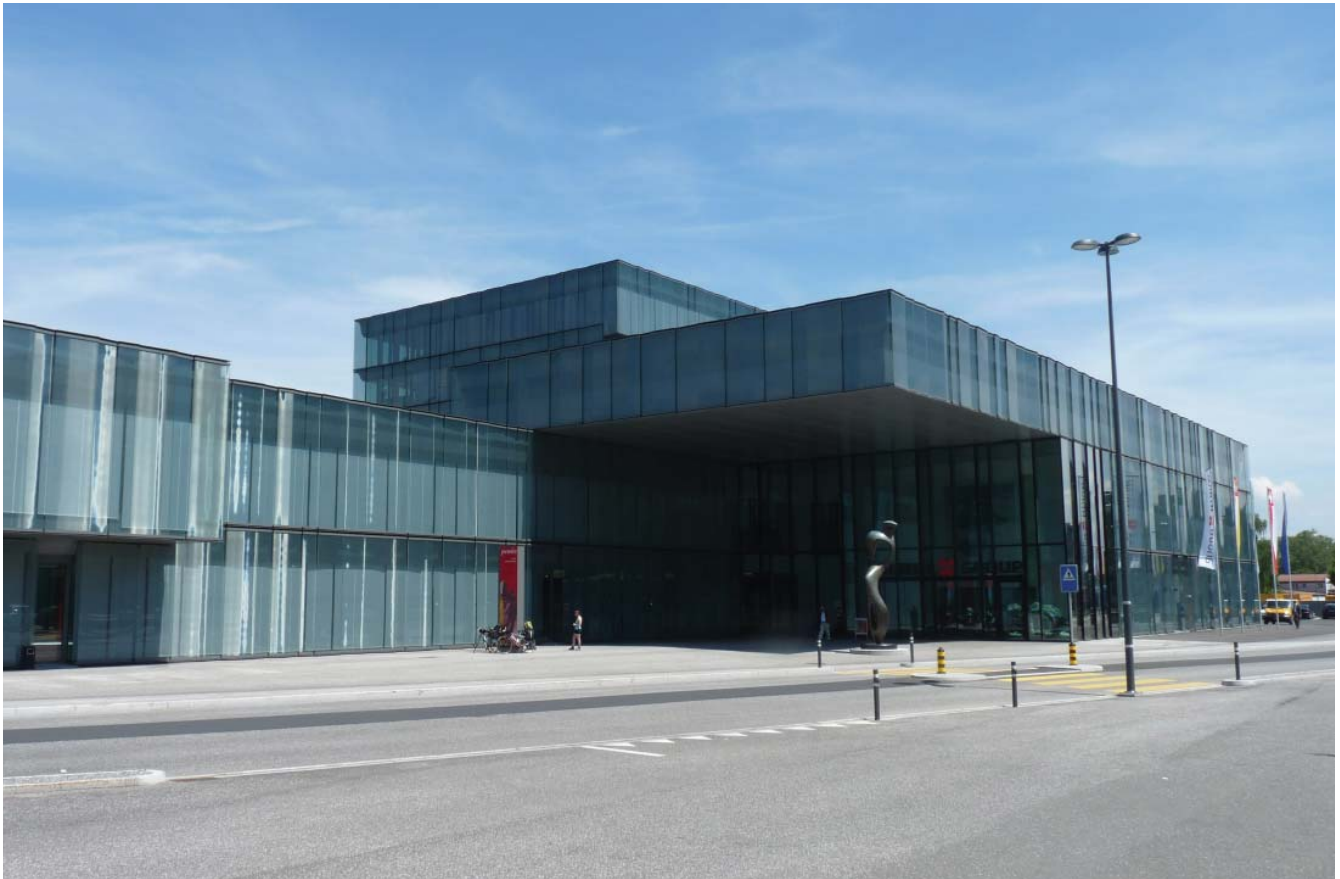
Abb. 1. Der Eingangsbereich des WÜRTH-Gebäudes vom Bahnhofplatz aus gesehen.
